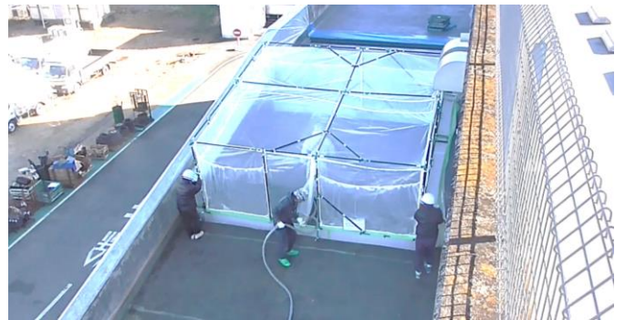
駐車場スロープ
