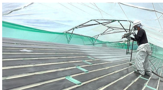
吹付作業 (切妻屋根)
