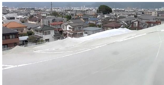
屋根部養生：飛散防止ネット
