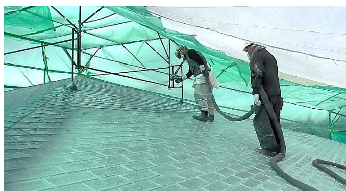
吹付作業 (方形屋根)
