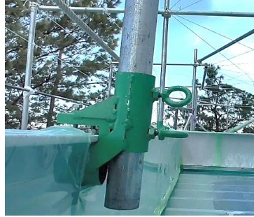
飛散対策（折板屋根庇）
