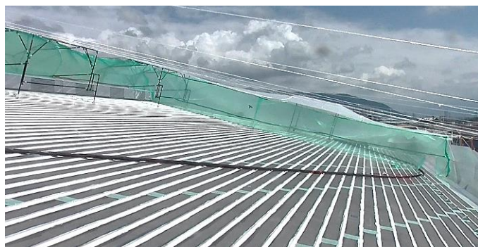
側面部養生：ノンスリップマスカー
